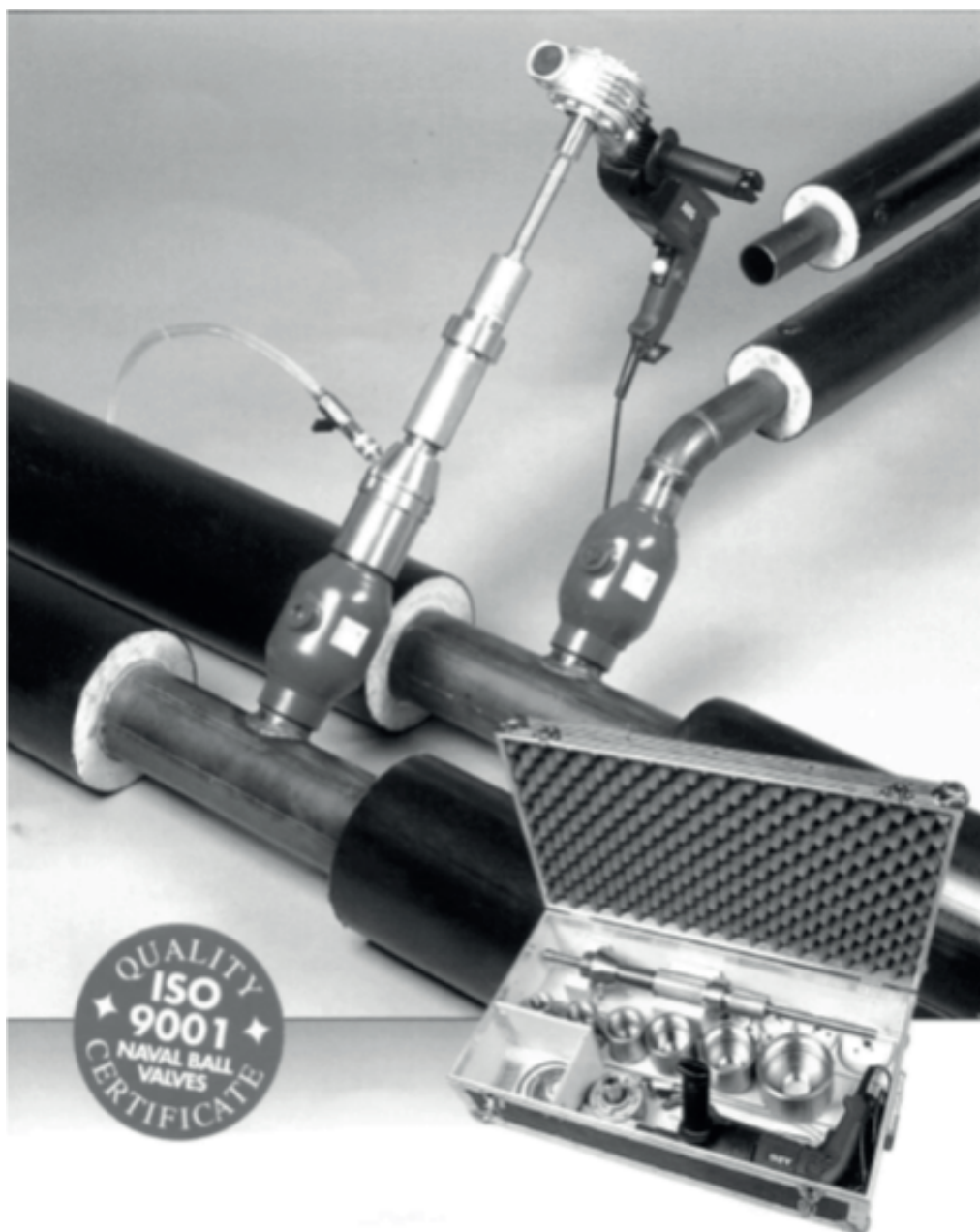
Rys.62. Wykonanie odgałęzienia na gorącym rurociągu
